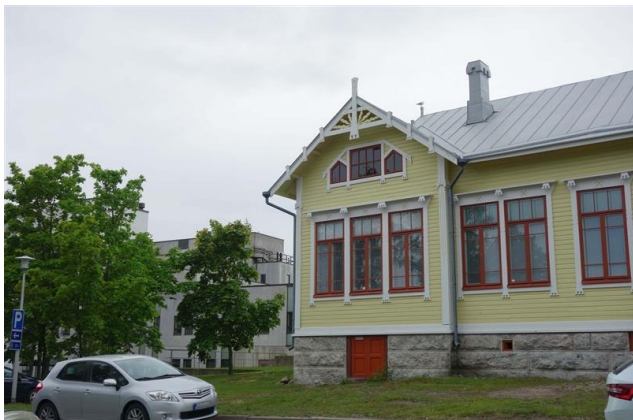
Kuvateksti: Vanha Kuumesairaala. Jugendtyylisen rakennuksen piirsi Onni von Zansen vuonna 1909. Takana aluesairaala. Kuvalagi: yleiskuva Kuvaaja: Liina Luoma Kuvausaika: 8.6.2022
