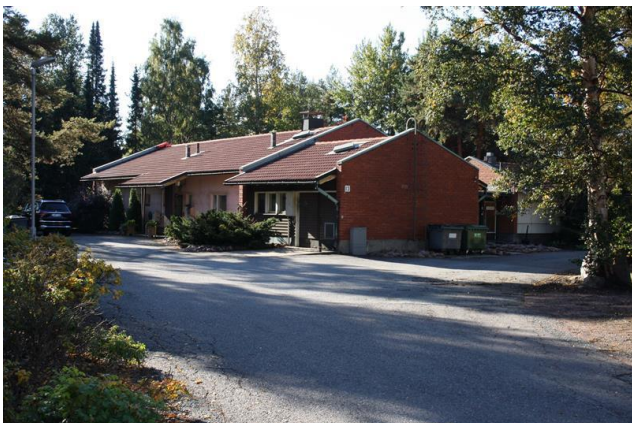
Kuvateksti: Teollisuuskadulla lähinnä tehtaan sisäänkäyntiä Kuvalagi: yleiskuva Kuvaaja: Niina Uusi-Seppä Kuvausaika: 2022
