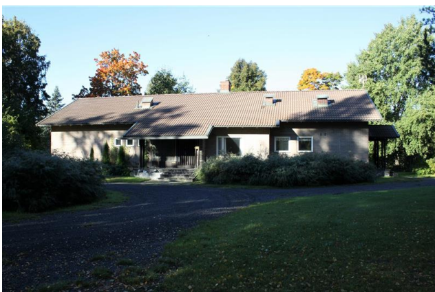
Kuvateksti: Kerhotalo aivan alueen pohjoispäässä (entinen johtajan asunto/Kemira?) Kuvalagi: yleiskuva Kuvaaja: Niina Uusi-Seppä Kuvausaika: 2022
