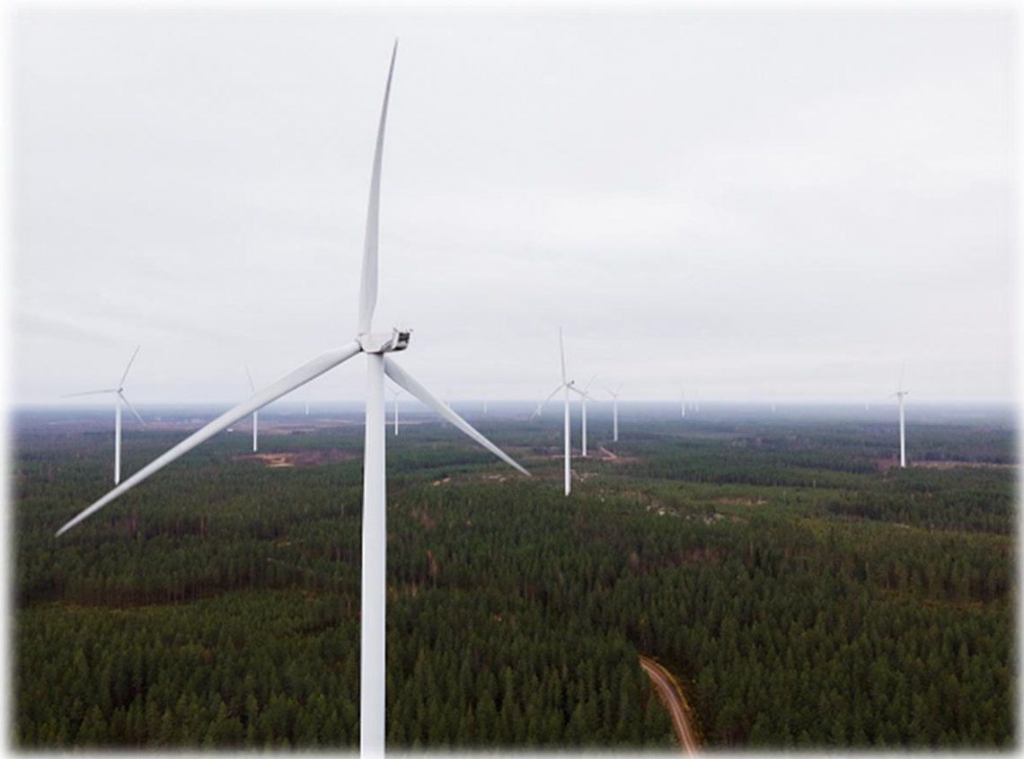
Tuulivoimaloita Kankaanpäässä, kuva Tomi Glad
