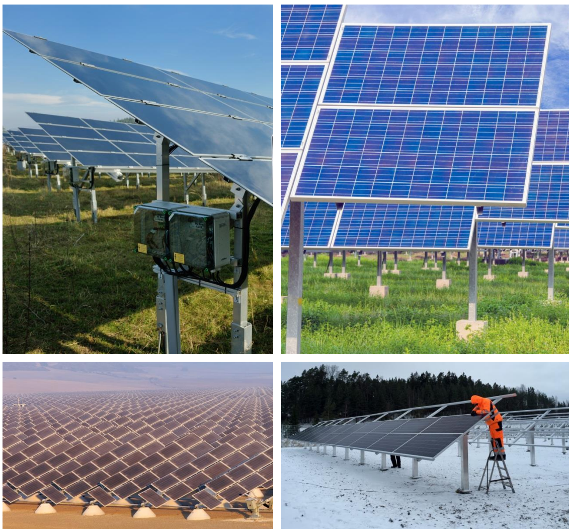
Kuva 2-7 Esimerkkejä erilaisista aurinkopaneelien maanvaraisista perustuksista. (Kuvat 1-3: Colourbox. Kuva 4 (oikealla alhaalla): Keravan Energia)
