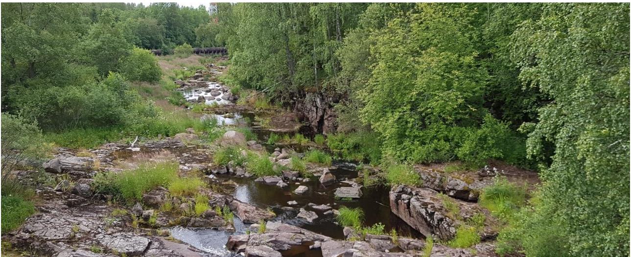
Kuva 2. Padon alapuolinen koski on kallioinen.
