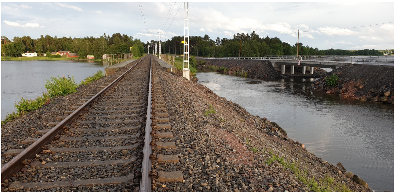
Sähköistetty rata Porin rautatieasemalta Tahkoluodon satamaan. Kuva: Sami Suominen
